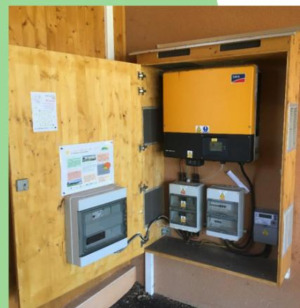
Le pilotage des onduleurs (qui permettent l'injection de l'énergie photovoltaïque sur le réseau) aide à réguler localement la tension pour éviter les contraintes en tension haute et ce après accord entre Enedis et le producteur concerné.
